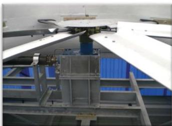
**BULLONERIA** di fissaggio viene fornita come standard su questo modello in ACCIAIO INOX o addirittura DUPLEX su richiesta.
